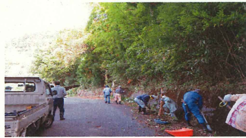
側溝の泥上げ
