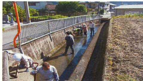
水路の泥上げ
