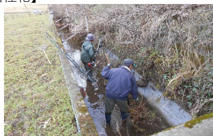
水路の泥上げ
