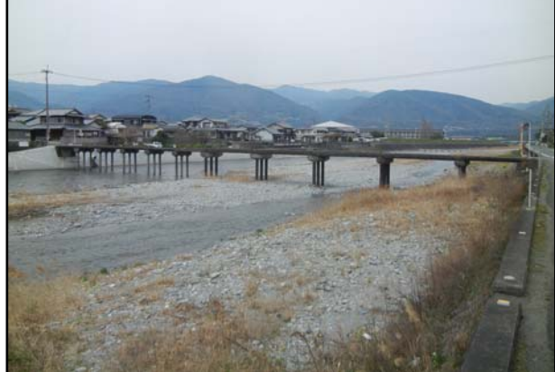
貞光地区：長橋（昭和34年建設）
