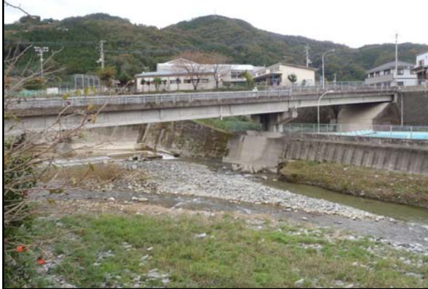
半田地区：木ノ内橋（昭和59年建設）
