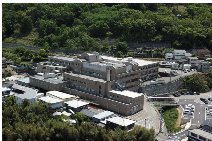
つるぎ町立半田病院
