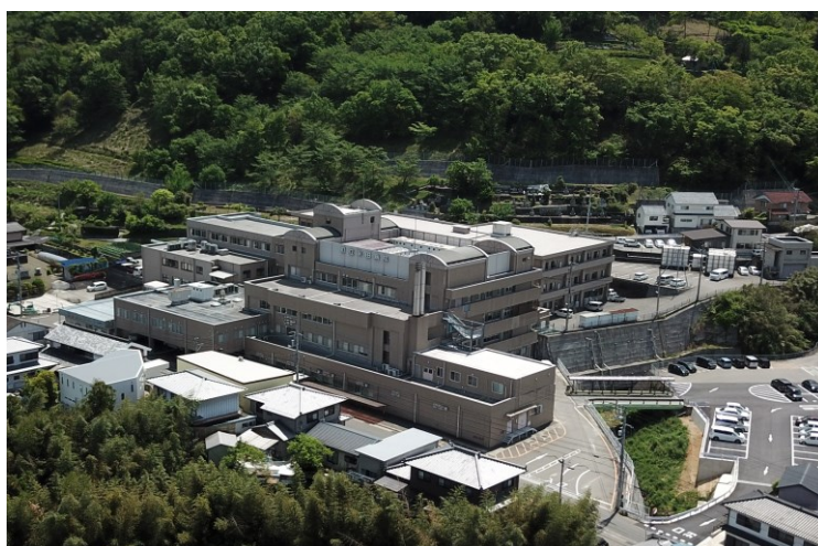
つるぎ町立半田病院
