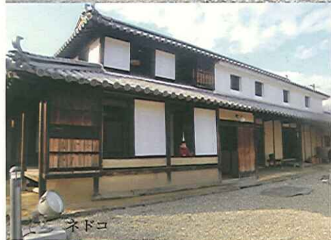
かやぶき屋根の母屋
